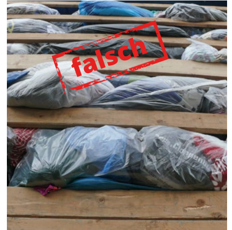
Bei geöffneter Plane sieht man, wie sich die Textilsäcke zwischen die Lattenkonstruktion schieben.
